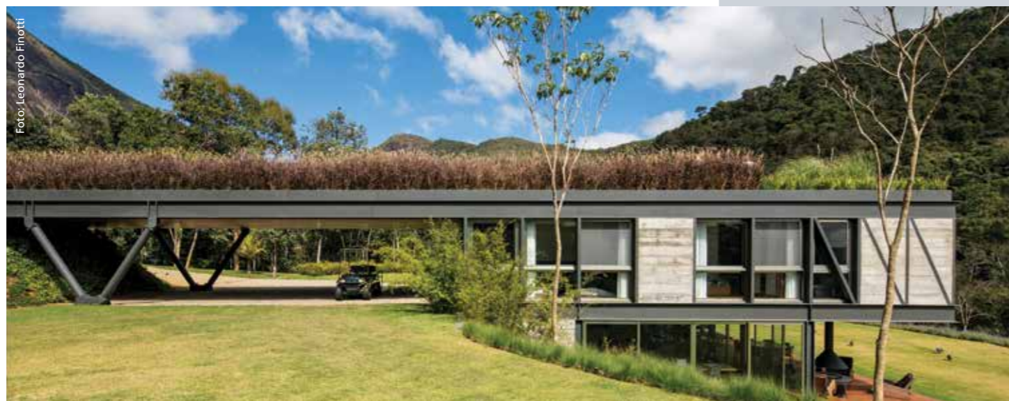
Foto: Leonardo Finotti Foto Residência JG
