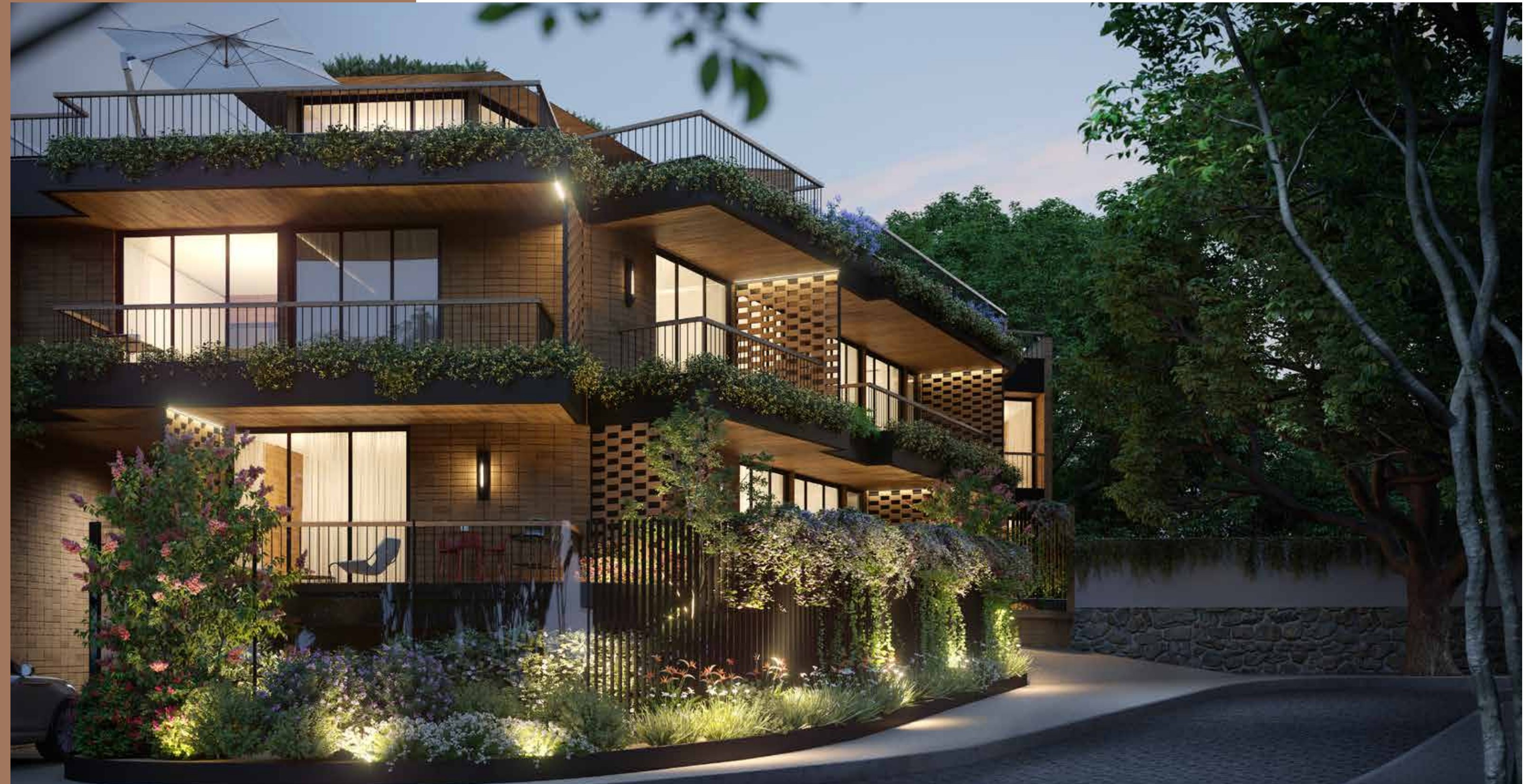
FACHADA NOTURNA :: VISTA LATERAL
